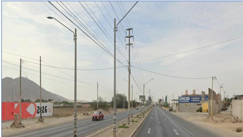
Imagen N° 30. Imagen del Sistema Eléctrico.
