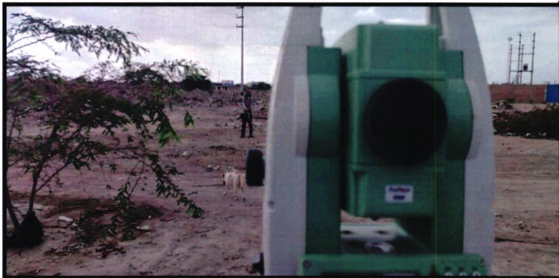
IMAGEN N°03. Levantamiento topográfico con Estacion Total Leica, levantamiento de puntos de control.
