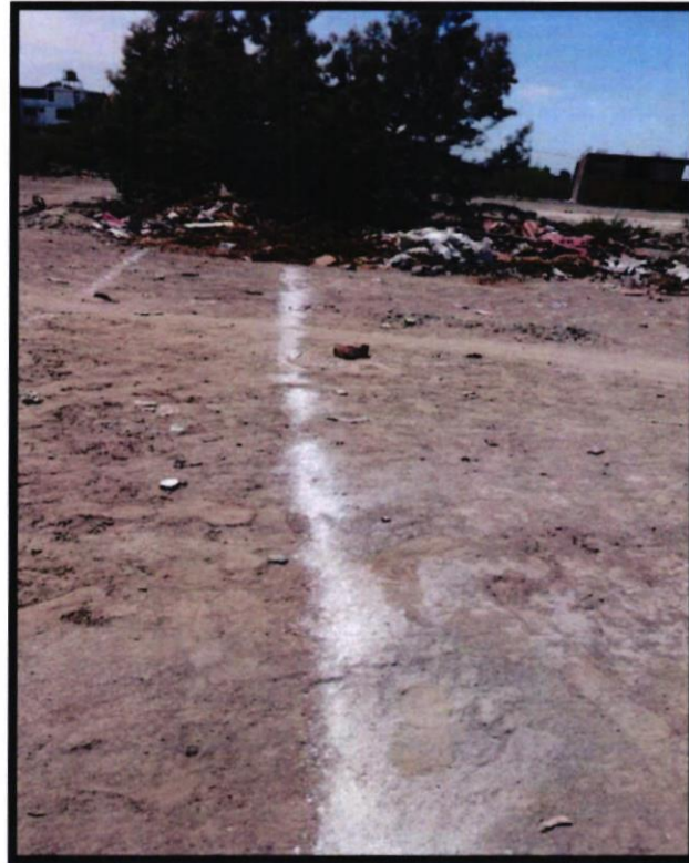
IMAGEN N°07 y 8. Se observa el replanteo y colocación de hitos del lote matriz.
