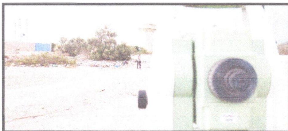
IMAGEN N°01. Levantamiento topográfico con Estacion Total Leica, levantamiento del Vertices del Predio.
