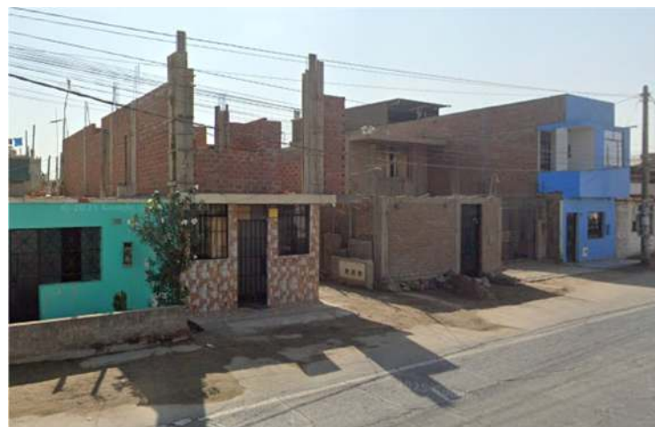
Sectores urbanos aledaños, empleo de sistemas estructurales de albañilería confinada sin supervisión.
