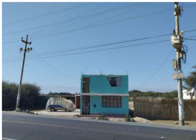
Redes Eléctricas existentes. (Frontis del predio).
