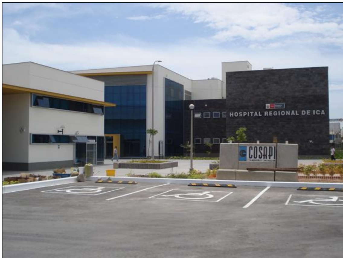
Imagen 41- Fotografía de Exterior de Hospital Regional de Ica (MINSA)
