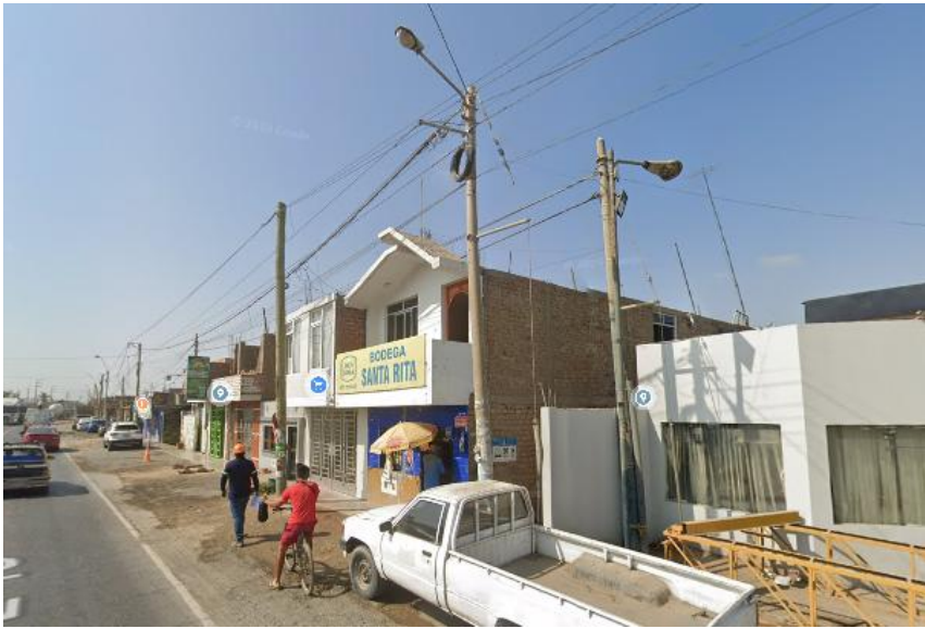
Redes Eléctricas existentes. (Frontis del predio).
