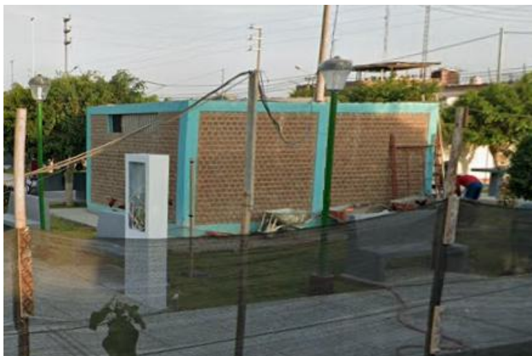
Información sobre pozo de agua en el sector. (IRHS 11 – 01 – 11 – 69)
