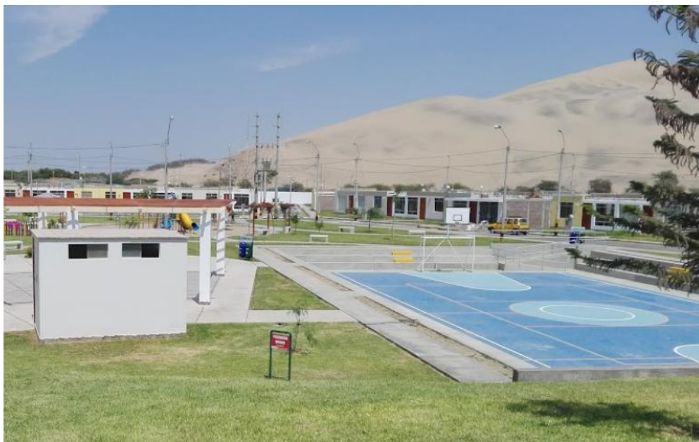
Imagen 21.- Características del entorno urbano cercano al predio.
