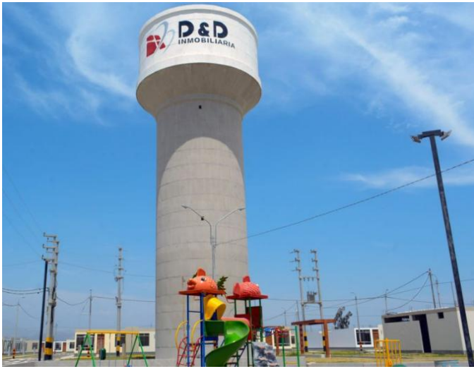
Imagen 47.-Nueva Infraestructura de dotación de agua.
