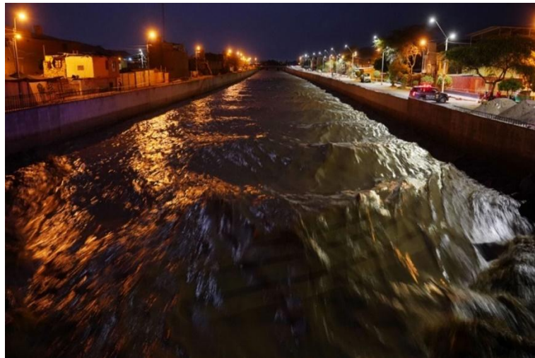
Imagen 25.- Rio Ica, principal condicionante sobre riesgo de desastres en el valle de Ica.
