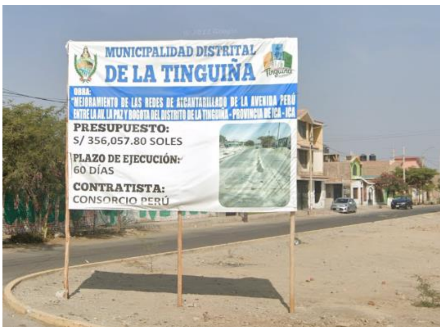
Imagen 43.-Obras de Saneamiento ejecutadas por la Municipalidad.
