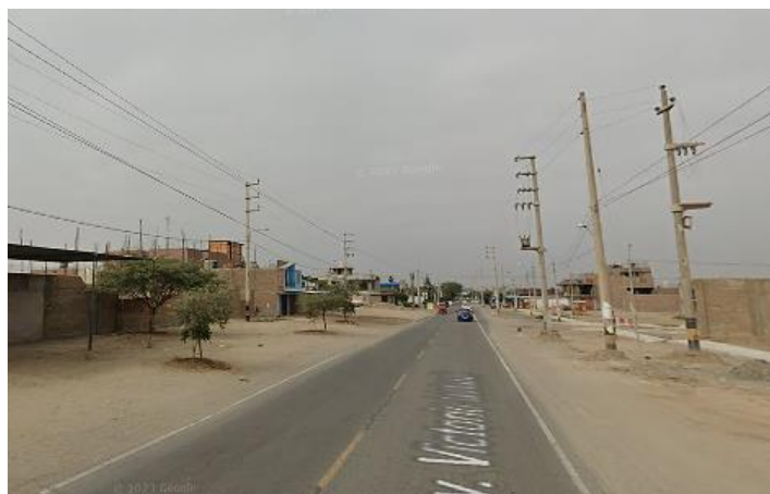
Imagen 41.-Redes de media tensión y alumbrado público
