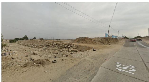
Imagen 47.-Diferencia de alturas predio y cauce de quebrada.
