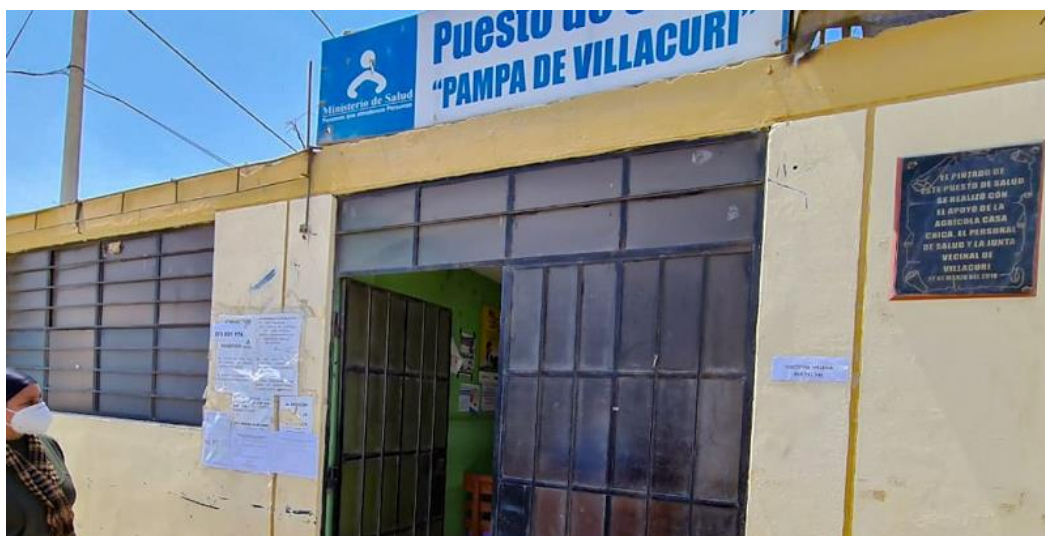
Imagen 63.- Puesto de Salud, Pampa de Villacuri.
