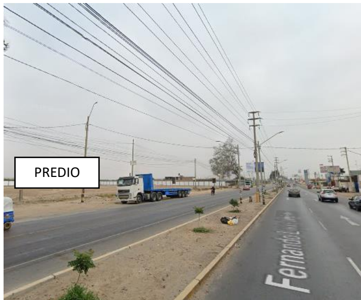
Imagen 28.-Redes de media tensión y alumbrado público
