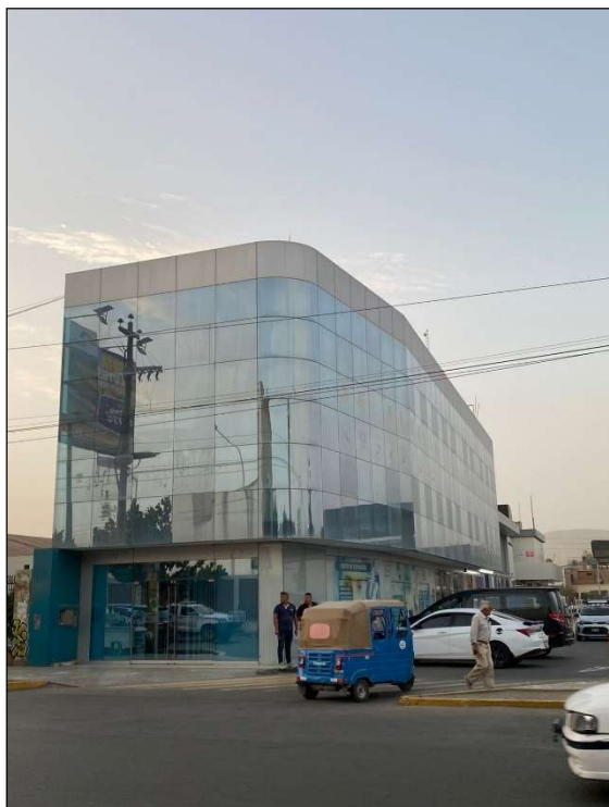
IMAGEN 61 :VISTA FRONTAL DE LA EDIFICACION
