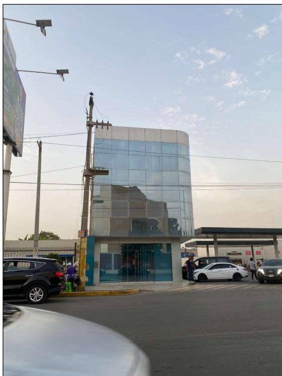
IMAGEN 63: VISTA FRONTAL DE LA EDIFICACION
