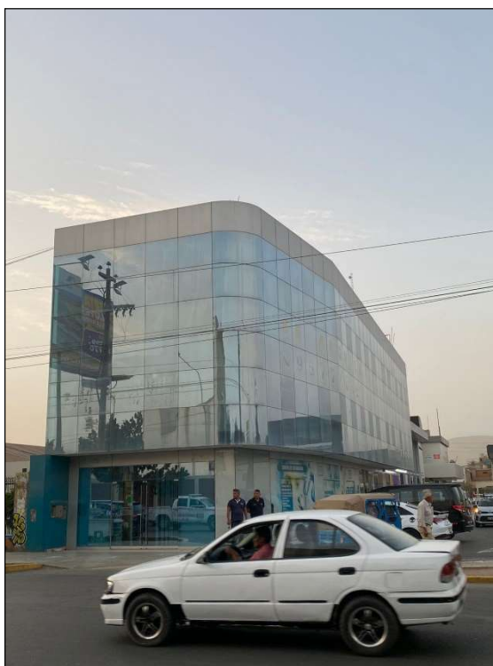
IMAGEN 64: VISTA FRONTAL DE LA EDIFICACION
