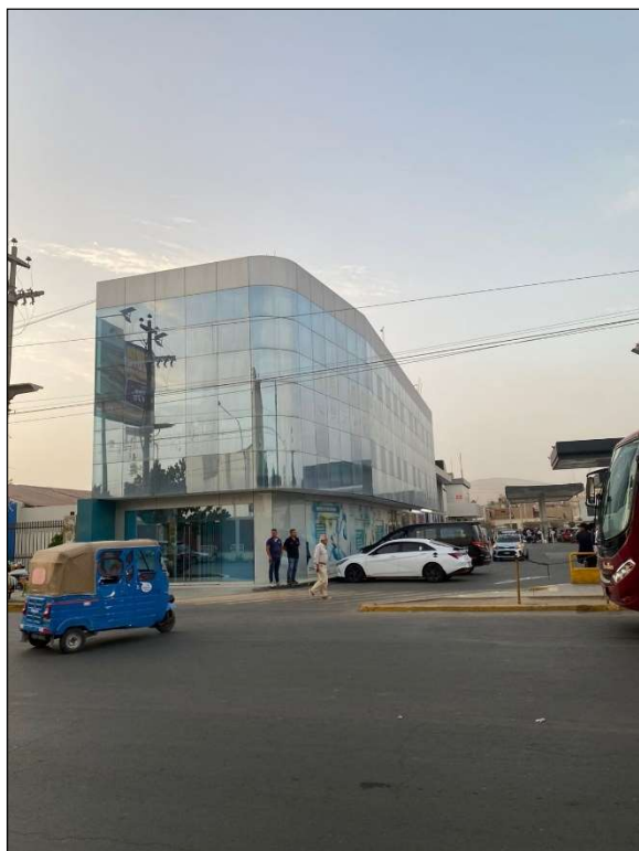
IMAGEN 65: VISTA FRONTAL DE LA EDIFICACION
