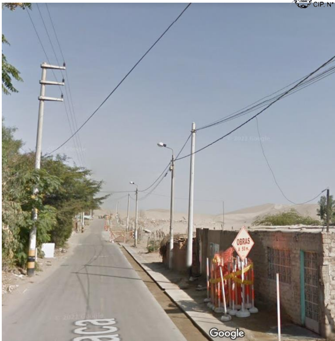
Imagen 39.-Infraestructura para el abastecimiento del servicio eléctrico
