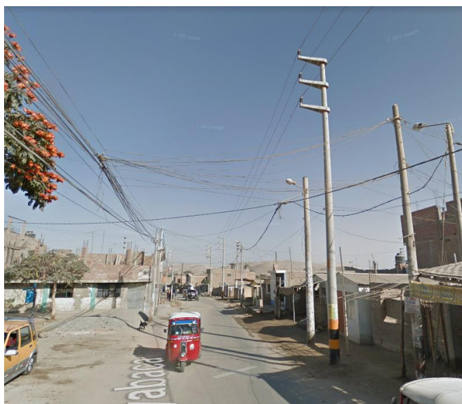
Imagen 22.- Vía vecinal Camino Comatrana (Se observa el alumbrado público)
