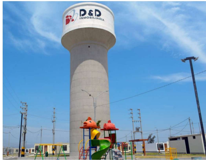
Imagen 48.-Nueva Infraestructura de dotación de agua.
