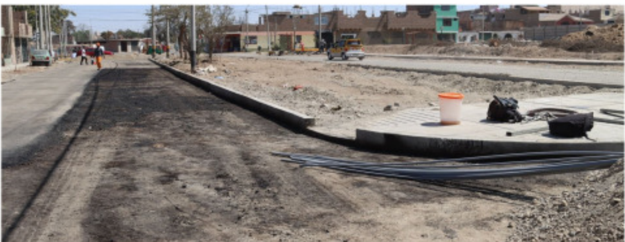
CONSTRUCCIÓN DE PISTAS, VEREDAS Y ÁREAS VERDES EN URB. LAS DUNAS - ICA.
