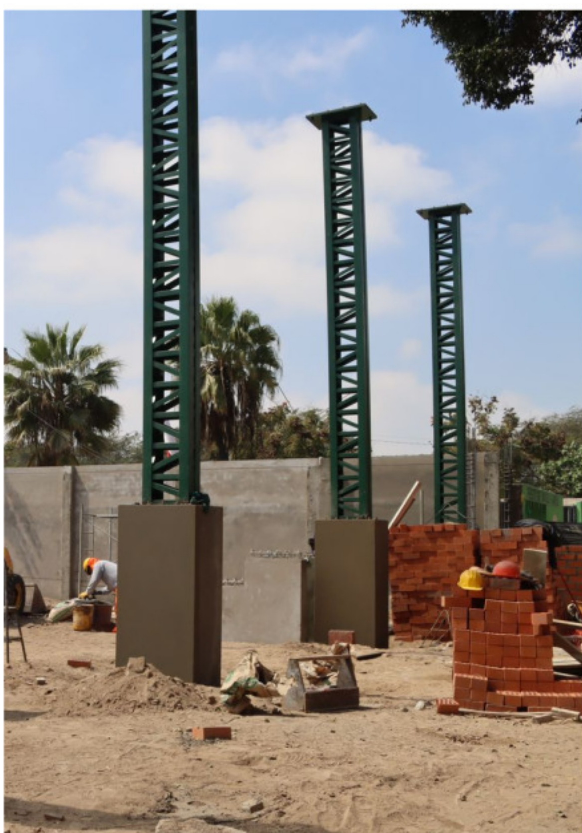
MEJORAMIENTO DE LOSA DEPORTIVA CON COBERTURA DE PROTECCIÓN SOLAR URB. LA PALMA
