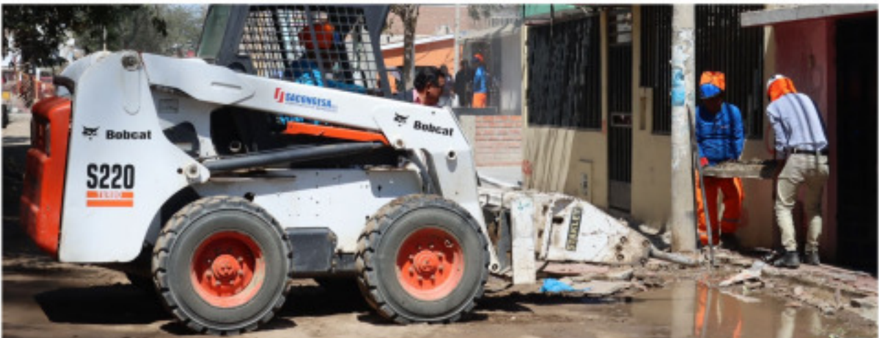
CONSTRUCCIÓN DE PISTAS Y VEREDAS Av. José Santos Chocano hasta la Av. Luís Valcárcel de la urbanización San Joaquín.
