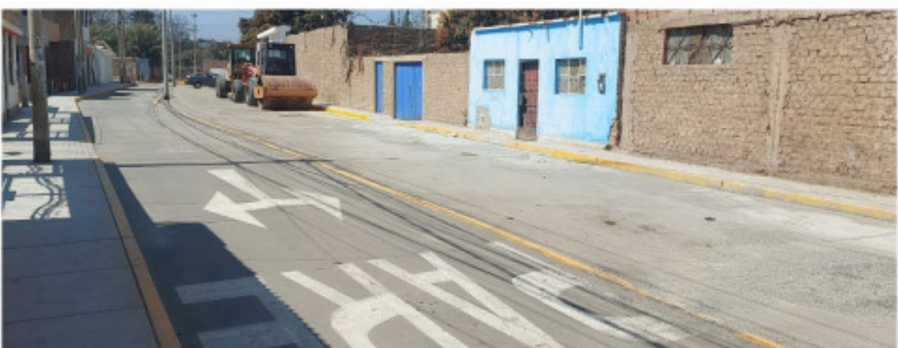
CONSTRUCCIÓN DE PISTAS, VEREDAS Y ÁREAS VERDES En barrio Santa Rosa - San Joaquín.
