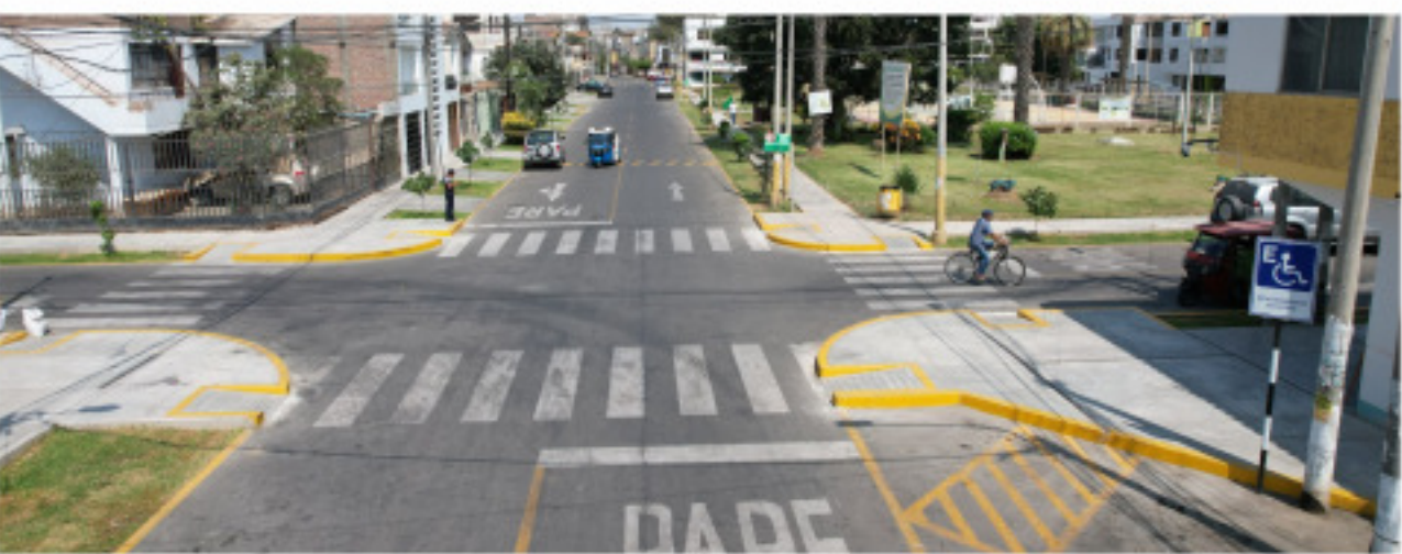
CONSTRUCCIÓN DE PISTAS, VEREDAS Y ÁREAS VERDES Urb. La Moderna II Elapa.
