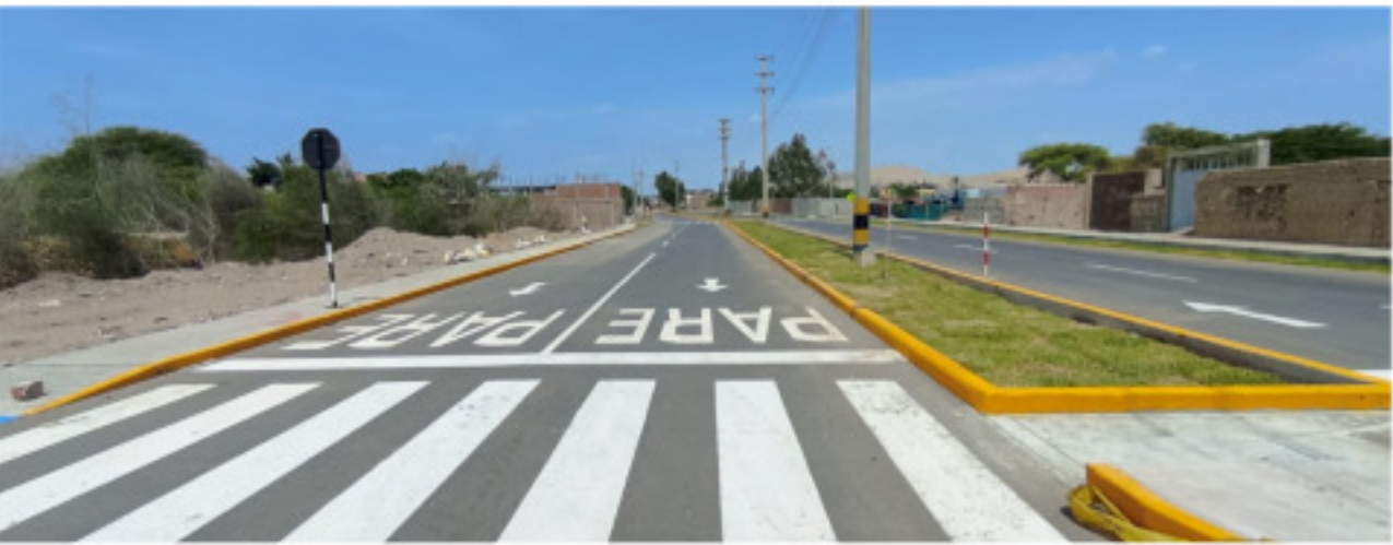
CONSTRUCCIÓN DE PISTAS Y VEREDAS AV. JOSÉ MARÍA EGUREN – URB. SAN JOAQUÍN CONECTANDO CON LOS SECTORES LA VICTORIA Y LA TIERRA PROMETIDA
