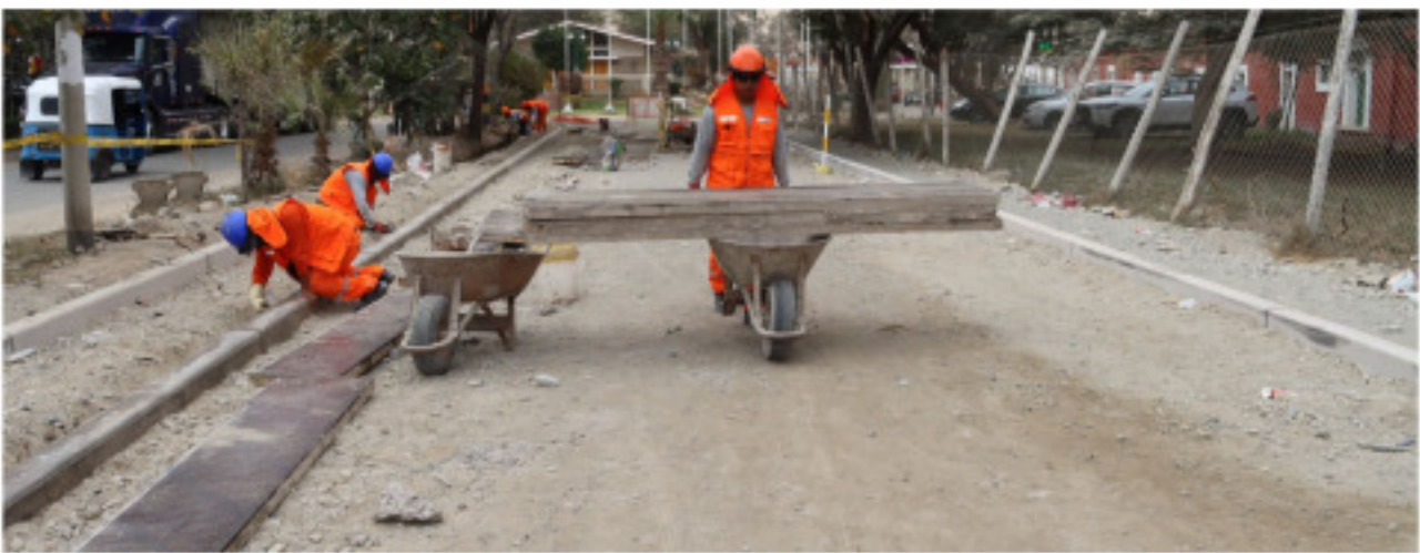
CONSTRUCCIÓN DE PISTAS, VEREDAS Y ÁREAS VERDES EN EL BALNEARIO DE HUACACHINA.
