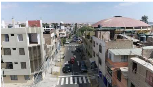
Remodelación de la Plazuela de Comatrana
