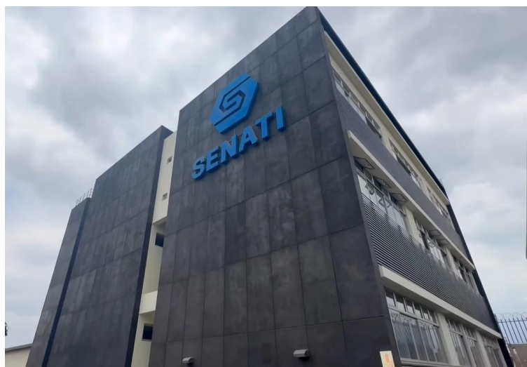
SENATI – Sede Subtanjalla (2.3 Km del predio aproximadamente)
