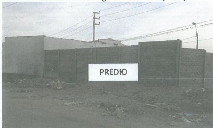
Imagen 24.-Redes de media tensión y alumbrado público
