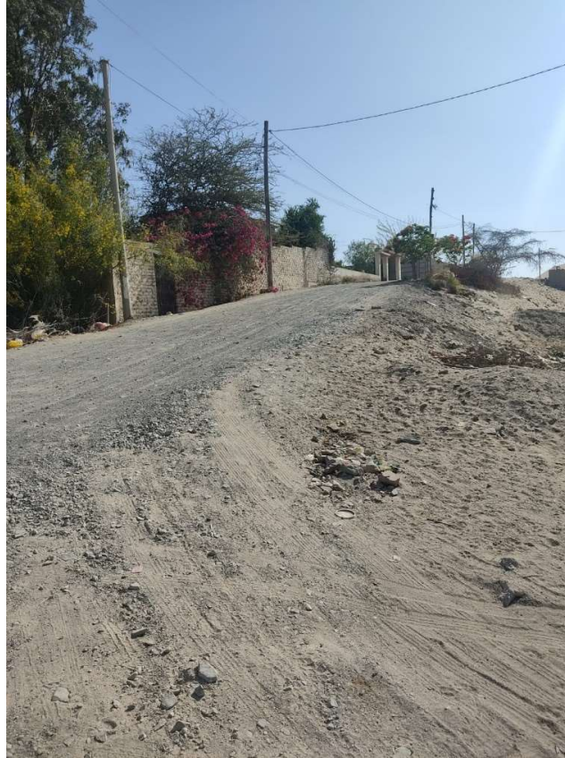
Imagen N°07. Vías accesibles al predio.
