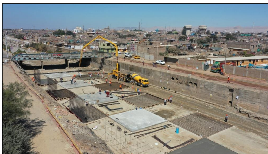
Imagen 51.- Obras para mitigación de riesgo en el río Ica.
