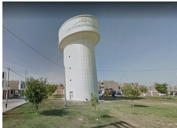
Imagen 44.- Reservorio Las Casuarinas
