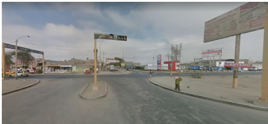
Imagen 59.- Cruce del camino hacia las Casuarinas y Carretera Panamericana Sur.
